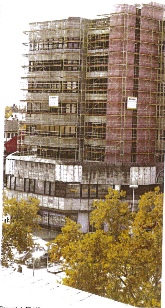
Eine zentrale Flüchtlingsverwaltung der Stadt Heilbronn wird in einer Büro-Etage im Turm des Wollhauszentrums geschaffen. Fotos: Guido Sawatzki
